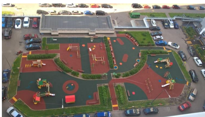
Площадки ПОСЛЕ выполнения работ.
